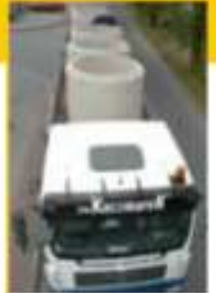
Transport prosto z fabryki na budowę
