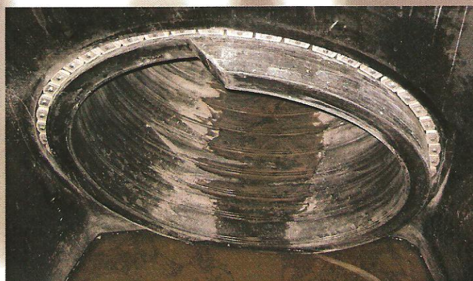
Kolektor ściekowy fi 1400.
